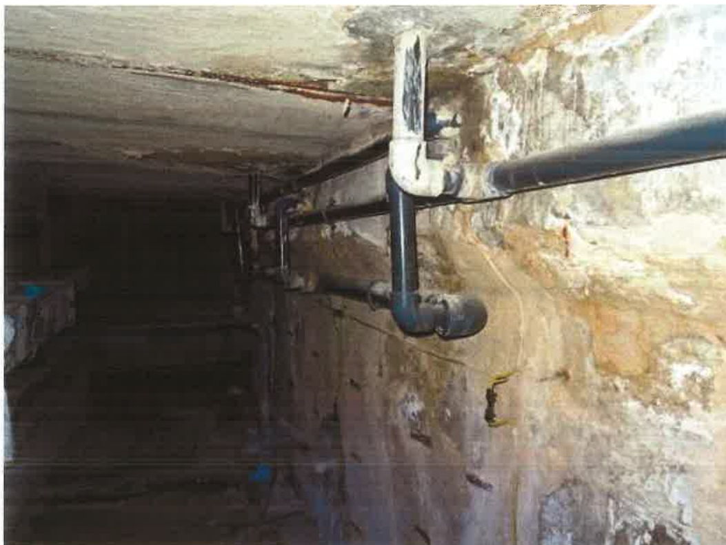
Fot. 11. Pomieszczenie niecki basenu
