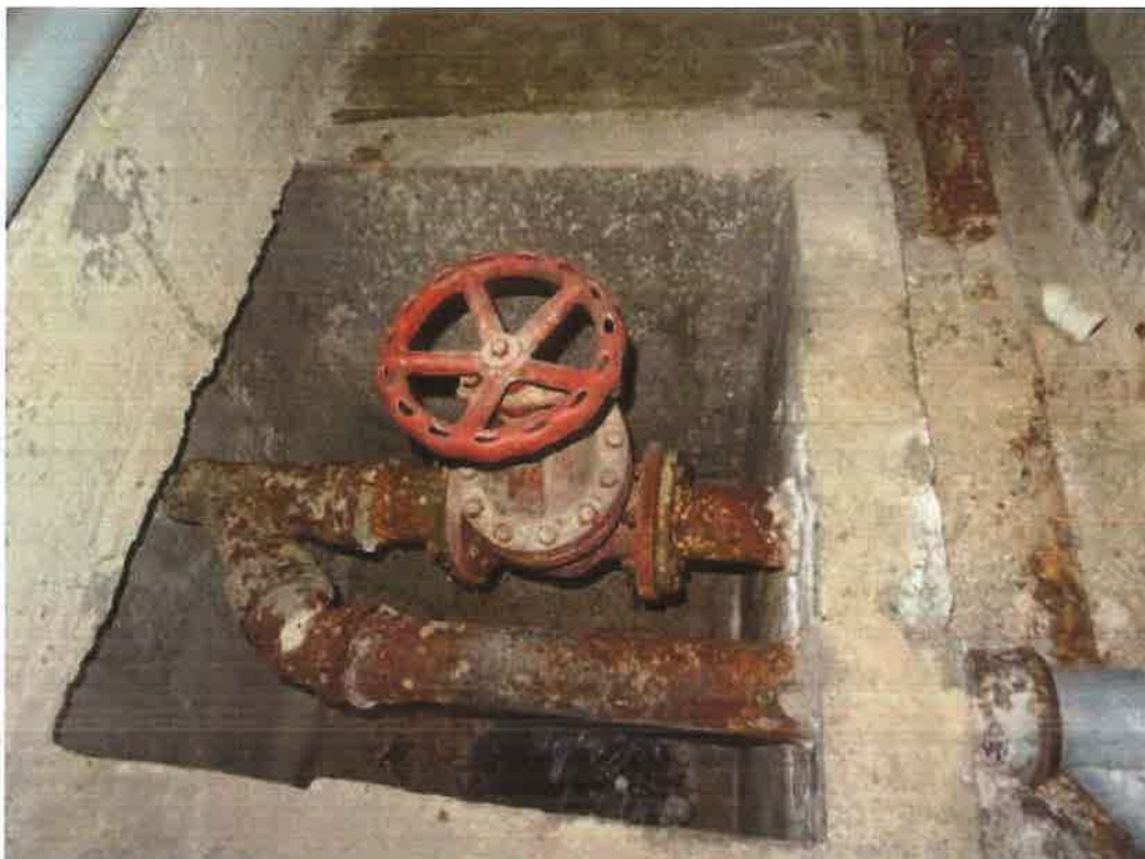
Fot. 23. Studzienka obok niecki basenu
