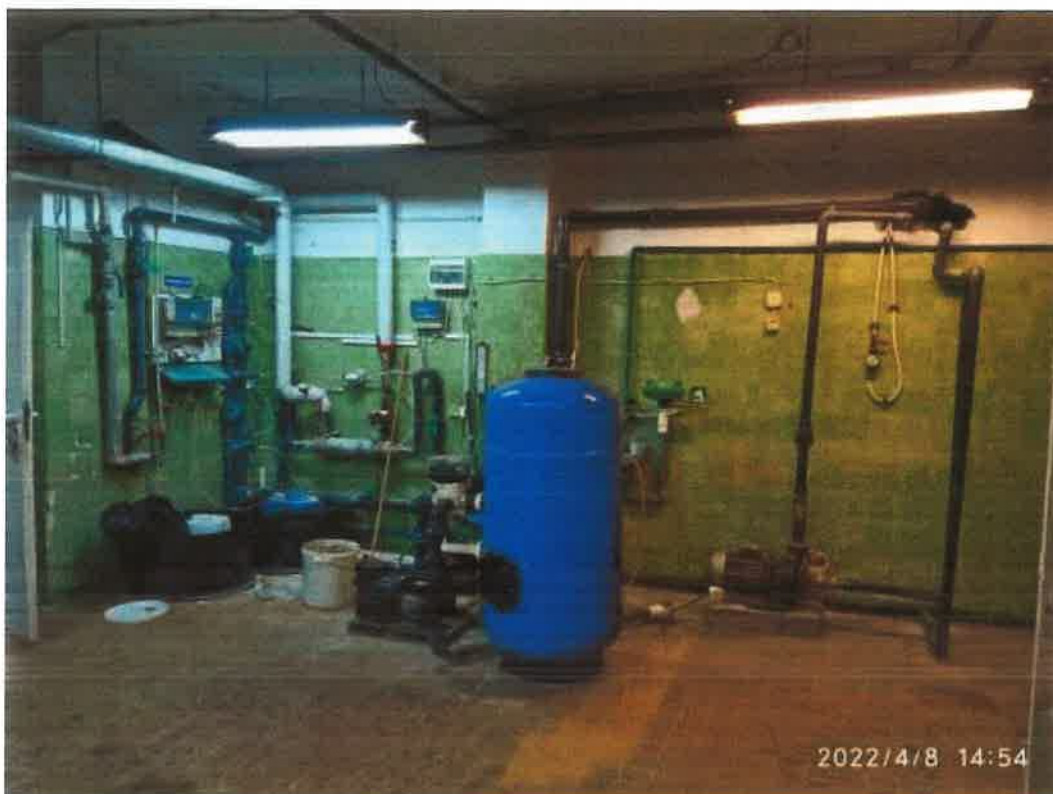
Fot. 25. Technologia basenu. Widok ogólny.
